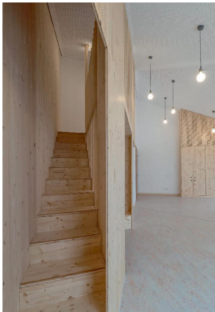
/ Sicherer Aufstieg: Die Faltschichten der Treppenstufen zu den oberen Stockwerken der Spielhäuser sind mit eingetüteten Antirutschprofilen ausgestattet.
