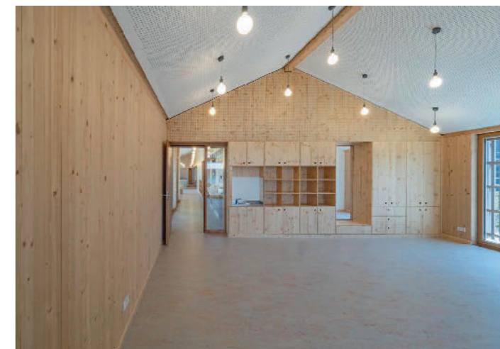
/ Die frontbündigen, akustisch wirksamen Blenden über den Schränken in den Gruppenräumen wurden über Schattenfugen an die Decken angepasst.
